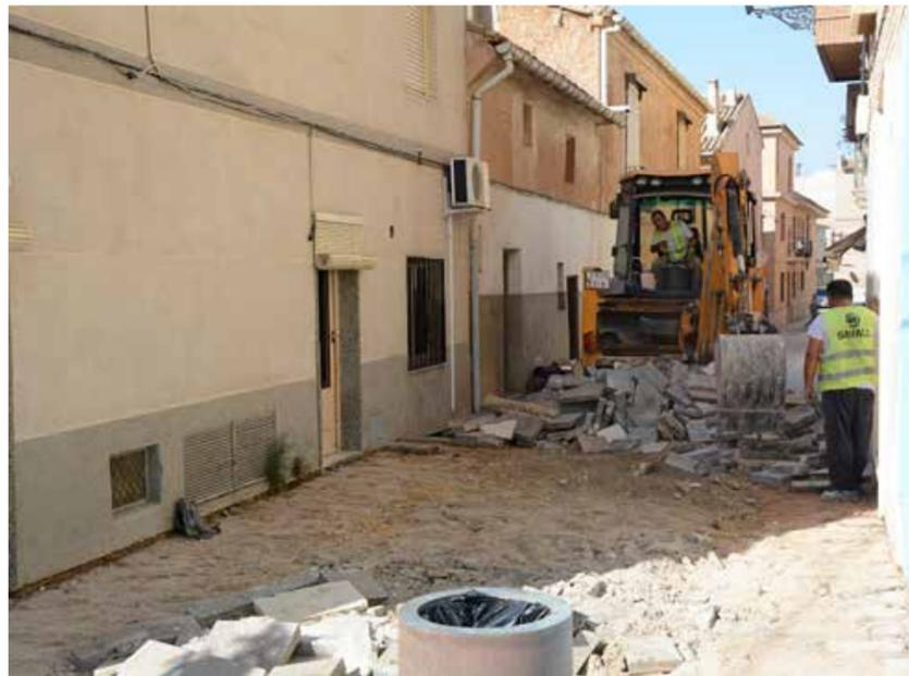
La actuación consistirá en la colocación de asfalto en la zona de la calzada y pavimento adoquinado en la zona de estacionamiento, mientras que las aceras se renovarán con un pavimento de baldosas prefabricadas de hormigón de alta resistencia a los deslizamientos. Se realizarán, además, actuaciones complementarias consistentes en la colocación de canalizaciones en las aceras para previsión de futuras renovaciones de servicios.
